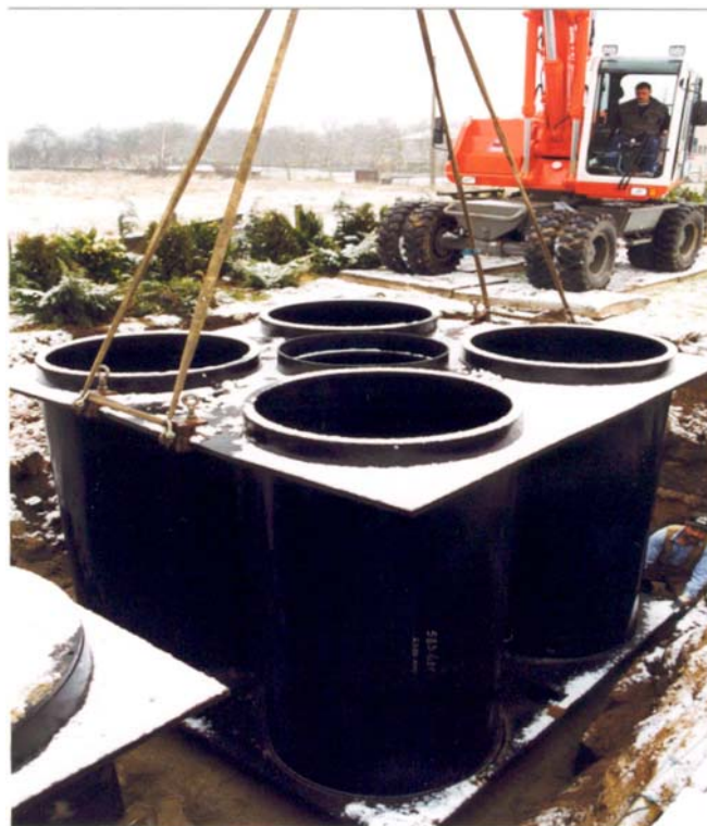
Abb. 4: Container-Lysimeterstation aus Polyethylen (PE-HD)
