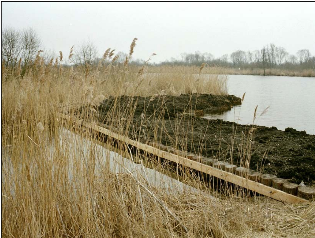
Abbildung 1: Verschluss von Entwässerungsgräben an der Peene
