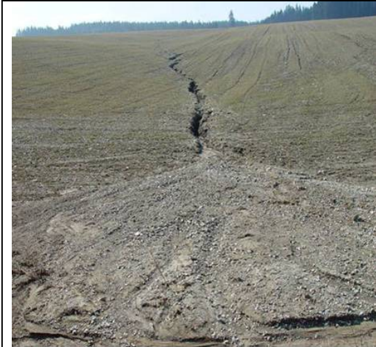
Abb. 2: Erosionsbahn mit Schwemmkegel nach einem Starkniederschlag (Foto: LfL, Dr. Schmidt)
